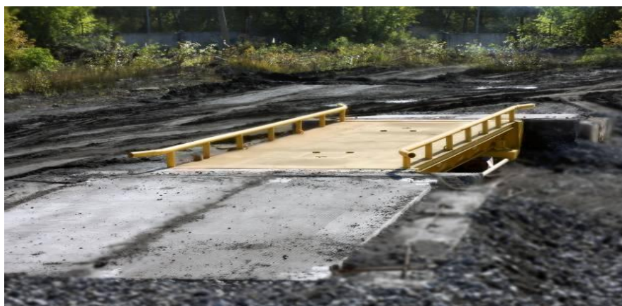
Рис. 1. Общий вид весов ЭМВС-А-М
