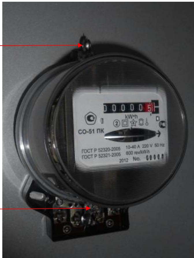
Рисунок 1. Общий вид счетчика и места пломбирования
