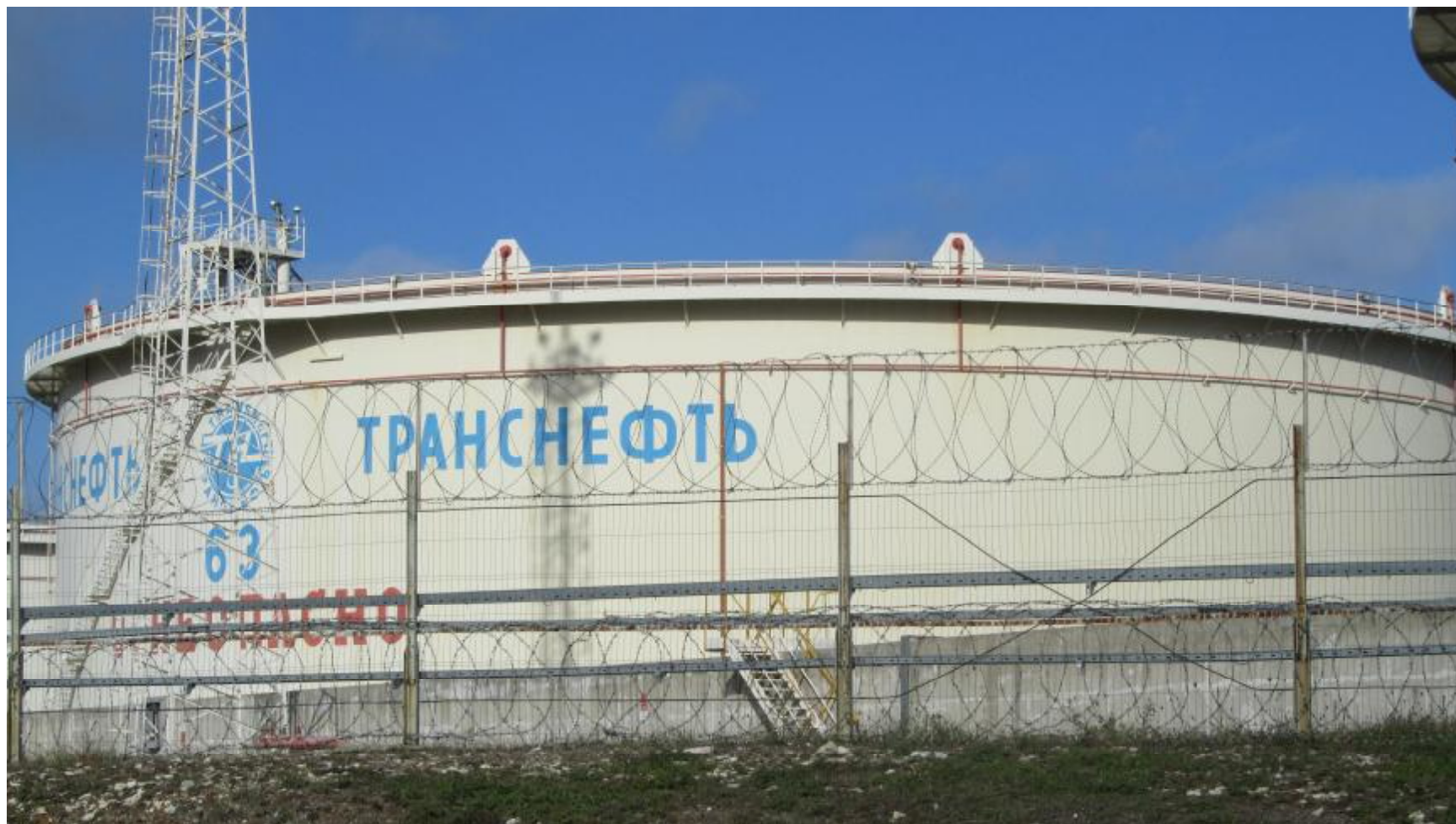
Рисунок 1. Общий вид резервуаров
