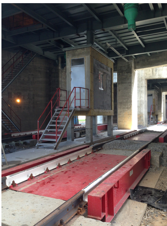
Рисунок 1- Общий вид весов вагонных ВС-В
