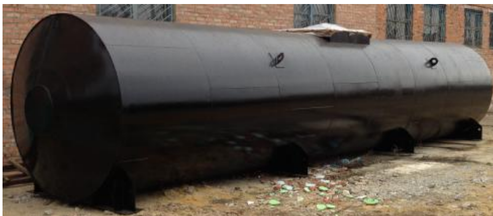
Фото 1. Общий вид резервуара.
