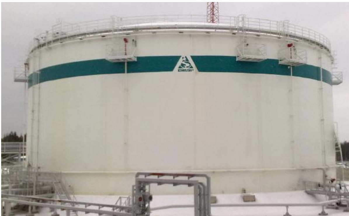
Рисунок 1 – Общий вид резервуара № 23981
