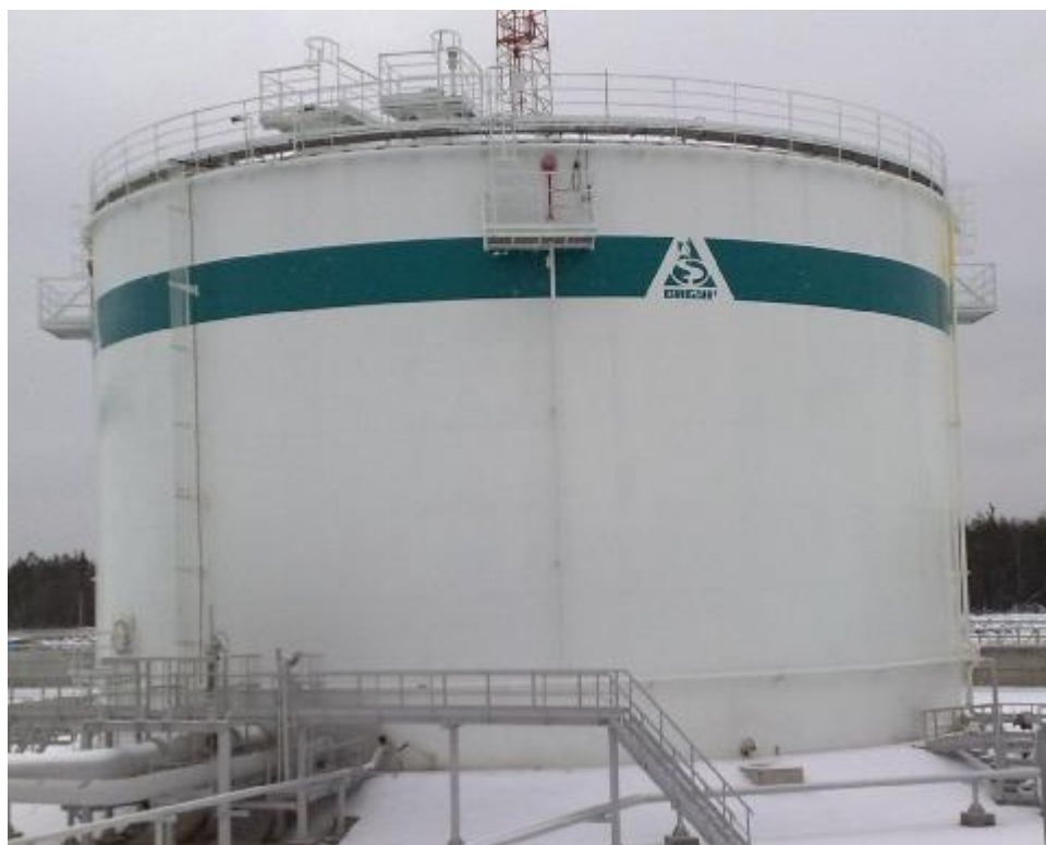
Рисунок 2 – Общий вид резервуара № 23984
