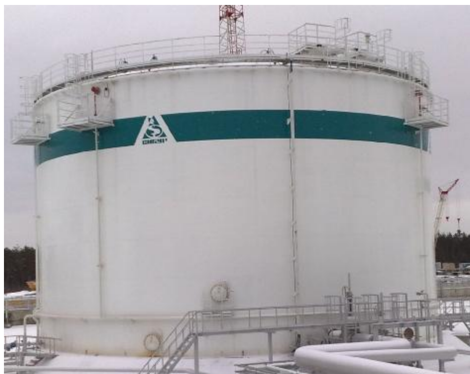
Рисунок 3 – Общий вид резервуара № 23985
