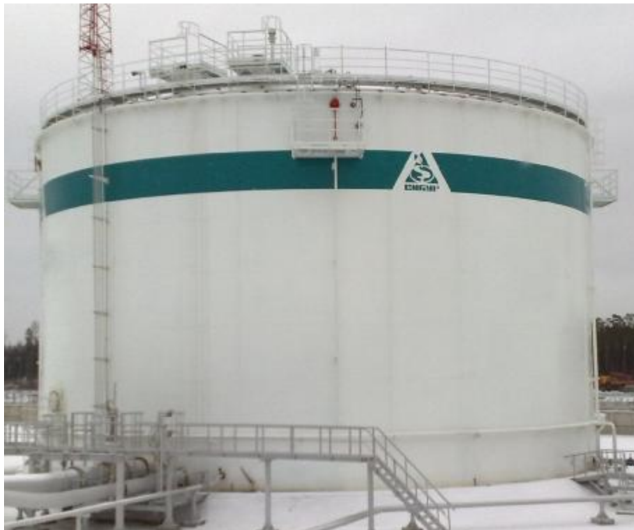
Рисунок 1 – Общий вид резервуара № 23983
