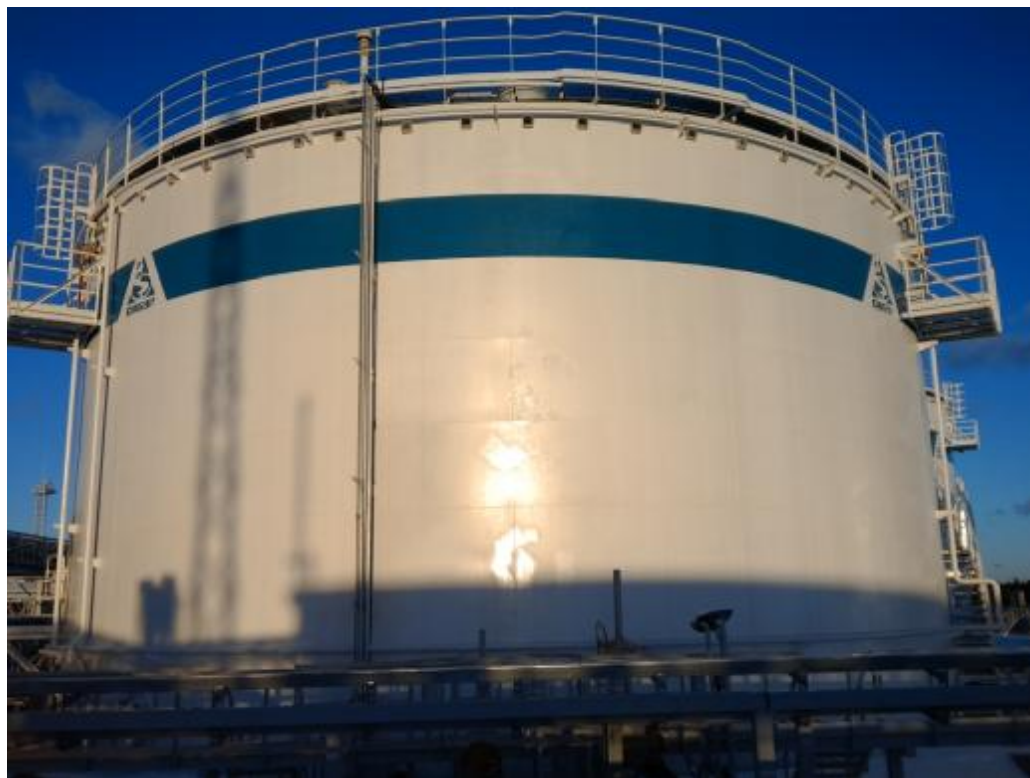
Рисунок 1 – Общий вид резервуара № 23986
