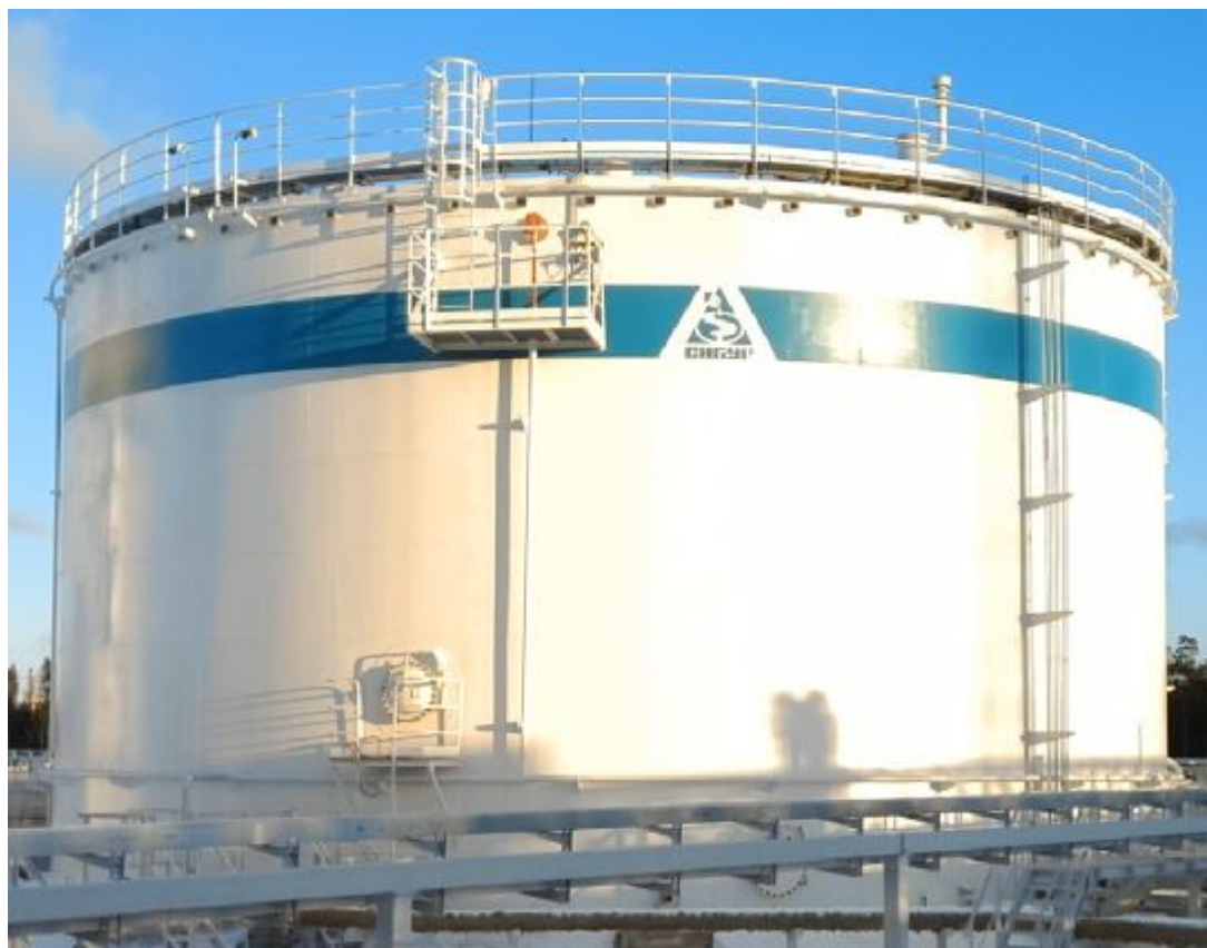
Рисунок 2 – Общий вид резервуара № 23987
