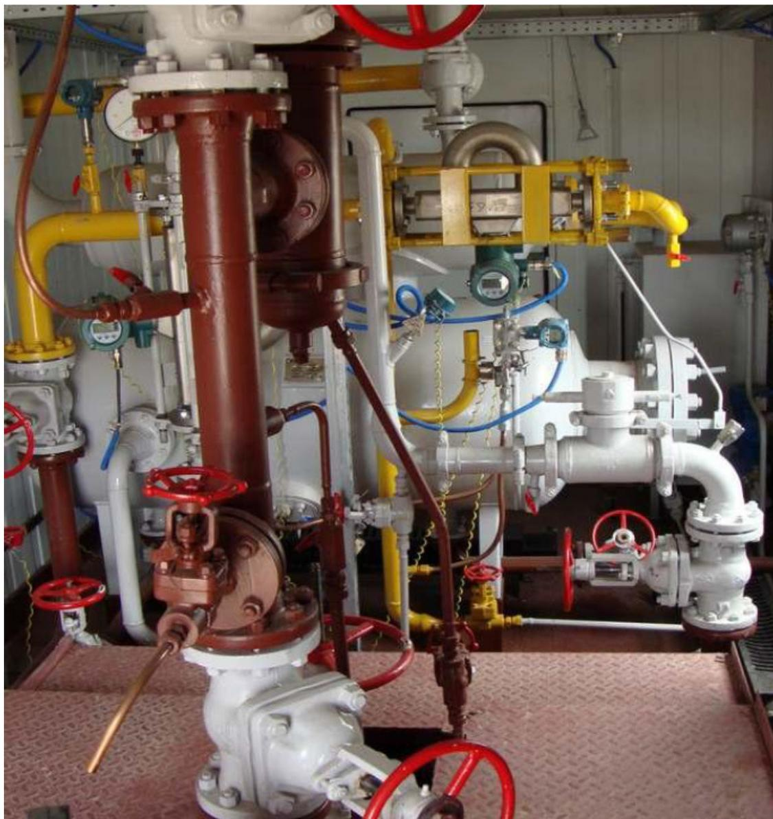
Рисунок 1 – Установка измерительная «Мера-ММ.71». Общий вид
