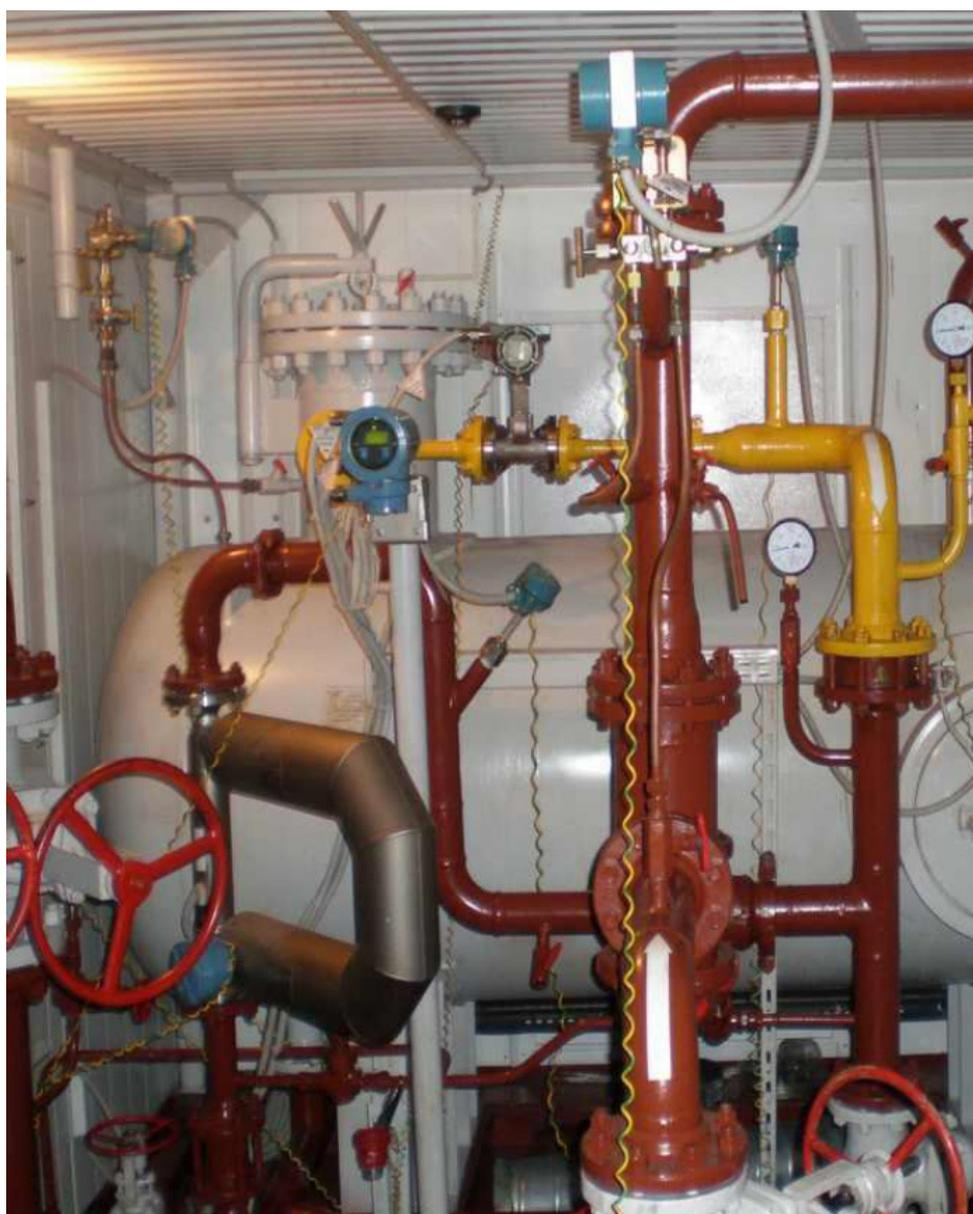
Рисунок 1а – Установка измерительная «Мера-ММ.71». Общий вид
