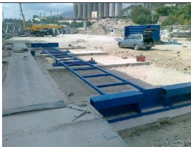
Г) Опорная рама «бесфундаментных» весов Модификация ВАТП 80-18-3-Н-2-БФ
