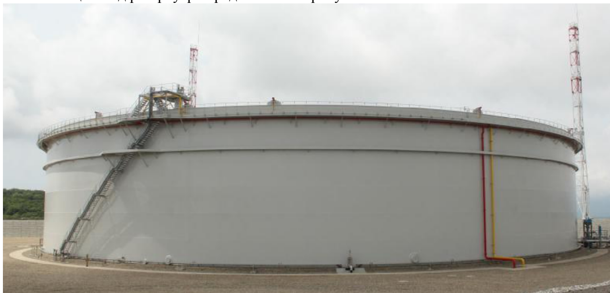
Рисунок 1 - общий вид резервуара
