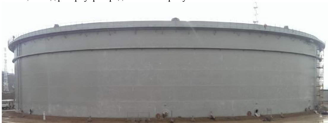
Рисунок 1 - общий вид резервуара
