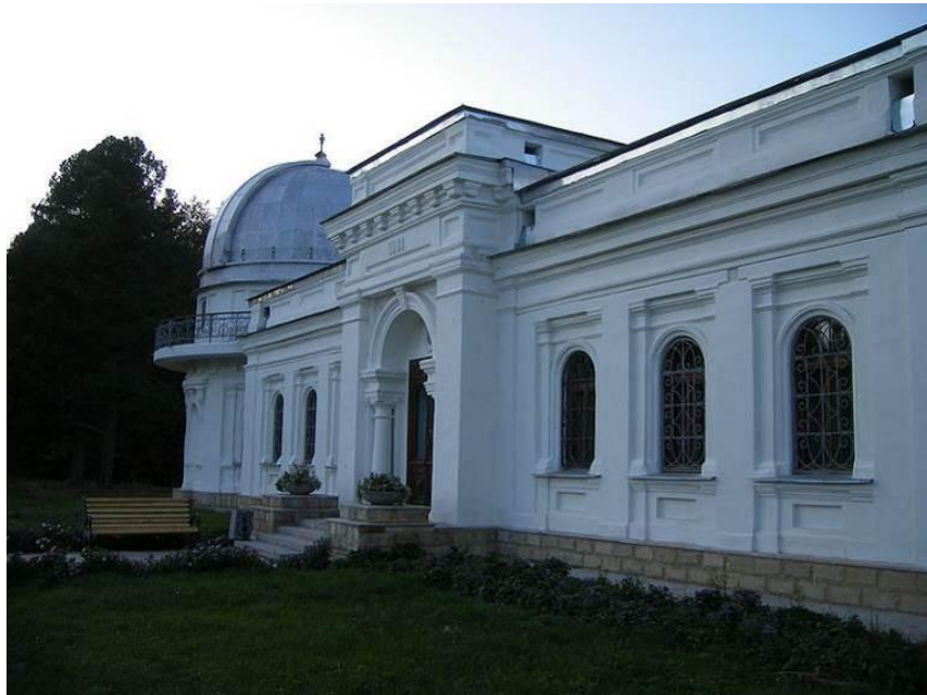
Рисунок 2 – Здание, где расположен опорный пункт №1.
