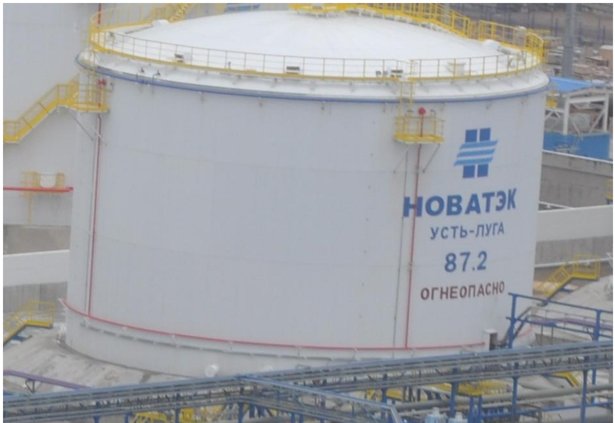
Рисунок 1 - Общий вид резервуара стального вертикального теплоизолированного РВС-10000
