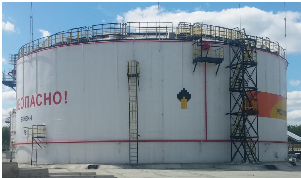
Рисунок 1 - Общий вид резервуаров вертикальных стальных цилиндрических РВСП-10000
