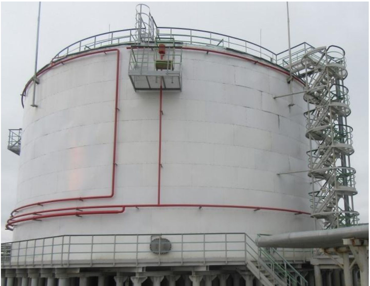
Рисунок 1 - Общий вид резервуара стального вертикального цилиндрического РВС-5000
