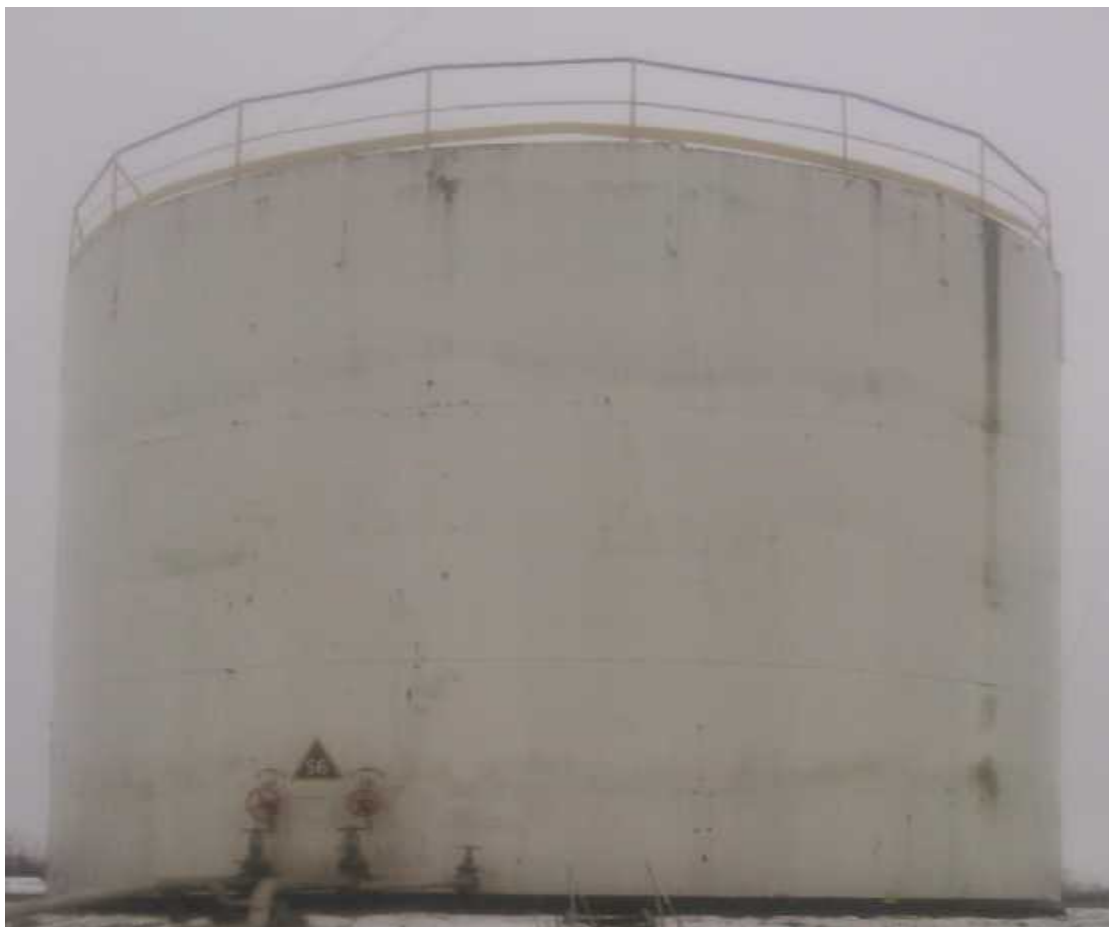
Рисунок 1 - Общий вид резервуара стального вертикального цилиндрического РВС-1000
