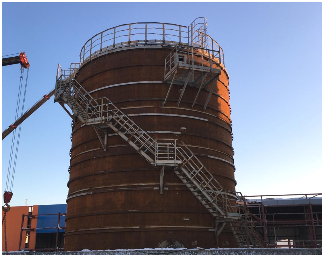
Рисунок 1 - Общий вид резервуаров
