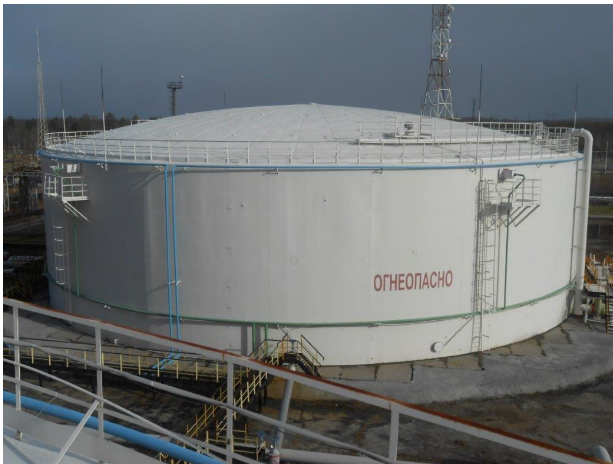
Рисунок 1 - Общий вид резервуара стального вертикального цилиндрического РВС-20000
