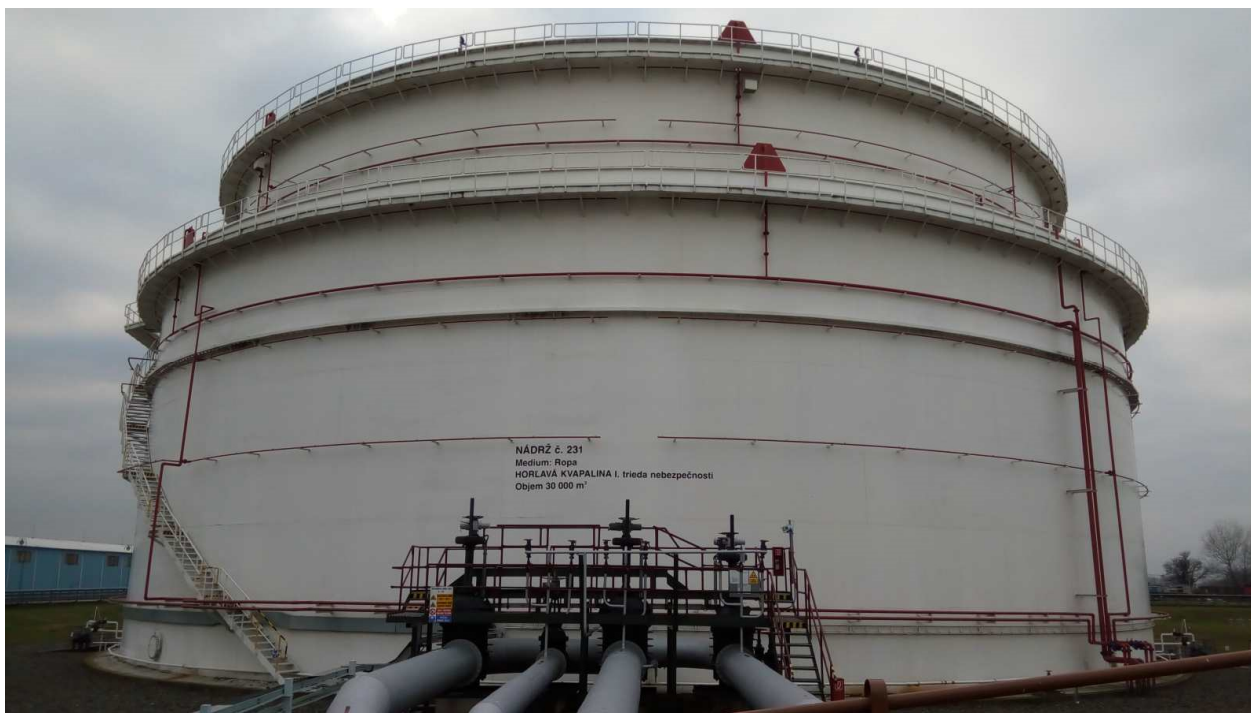
Рисунок 1 – Общий вид резервуара РВСПК-30000 зав.№ 231
