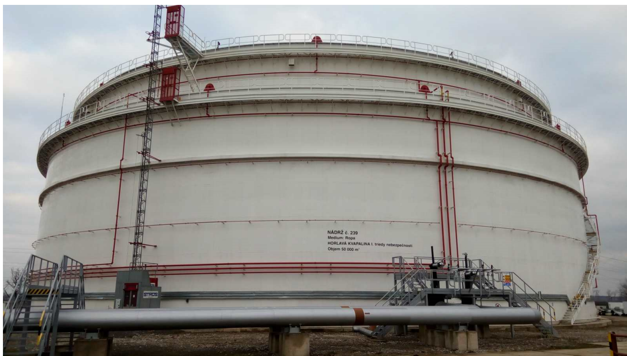
Рисунок 3 – Общий вид резервуара РВСПК-50000 зав.№ 239
