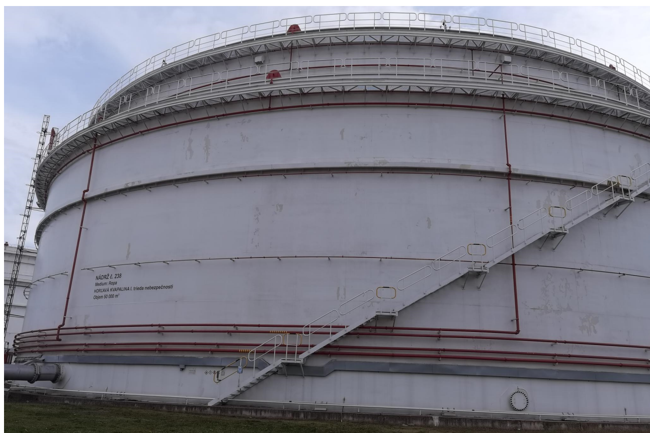
Рисунок 2 – Общий вид резервуара РВСПК-50000 зав.№ 238
