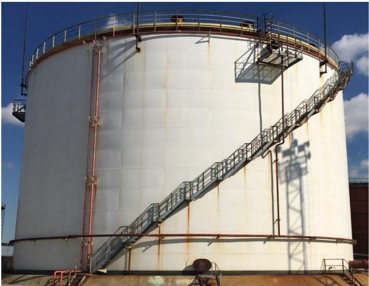
Рисунок 1 - Общий вид резервуара стального вертикального цилиндрического РВСП-10000
