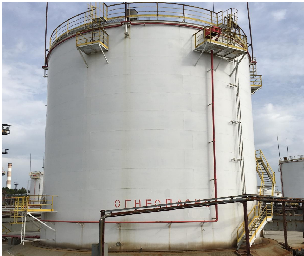
Рисунок 1 - Общий вид резервуара стального вертикального цилиндрического РВСП-3000
