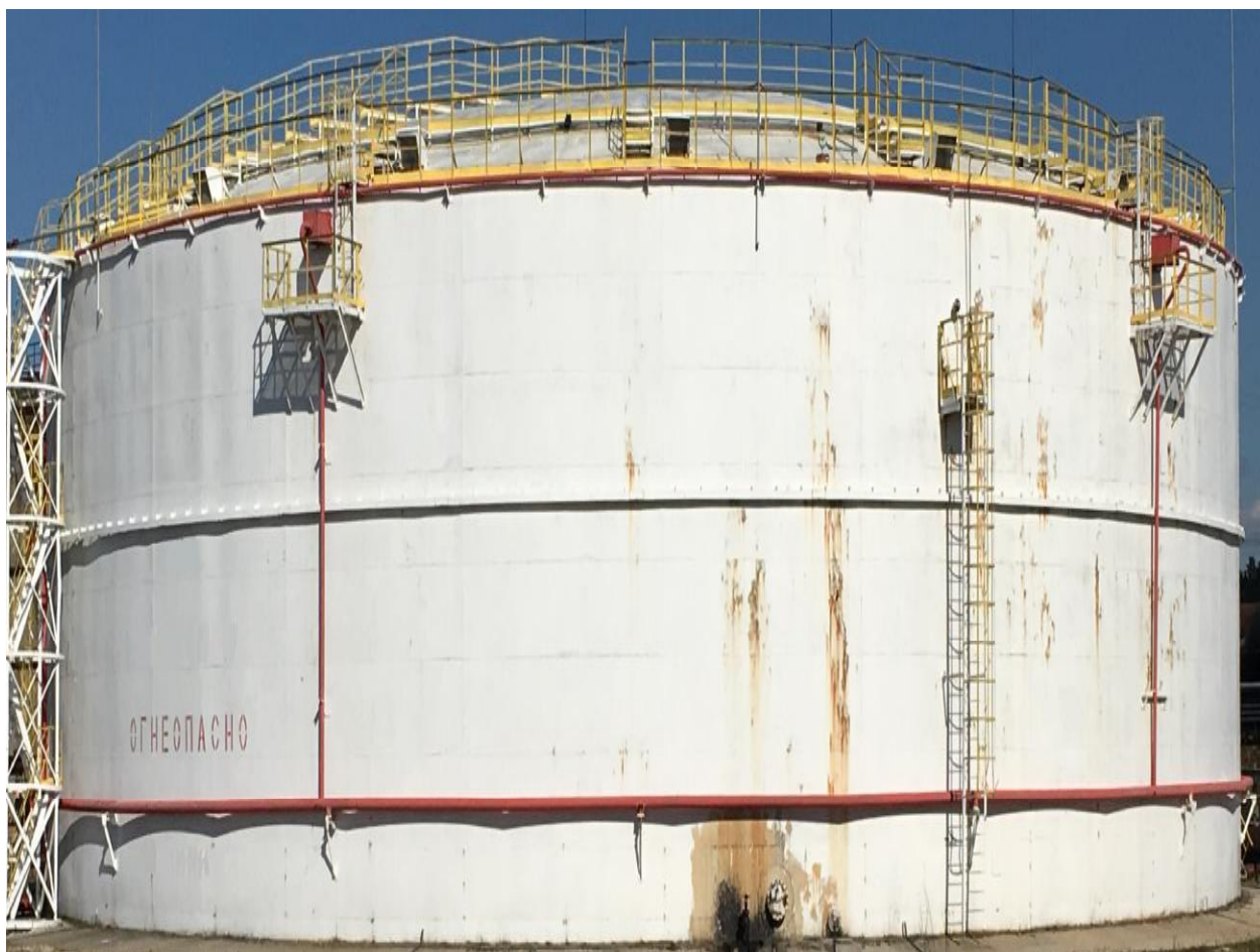
Рисунок 1 - Общий вид резервуара стального вертикального цилиндрического РВСП-20000
