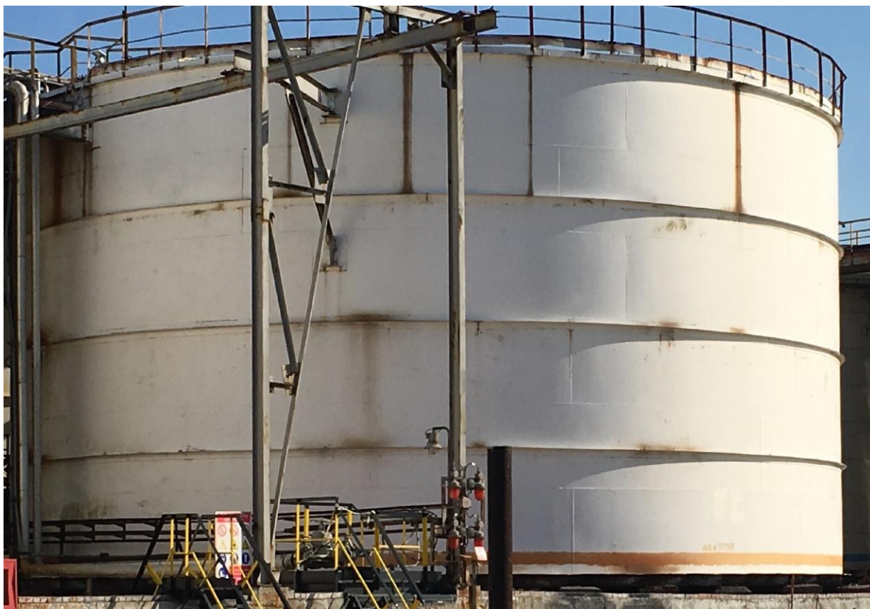
Рисунок 1 - Общий вид резервуара стального вертикального цилиндрического РВС-2000
