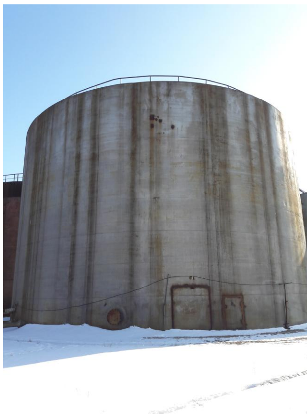
Рисунок 3 - Общий вид резервуара РВС-3000 № 5/5
