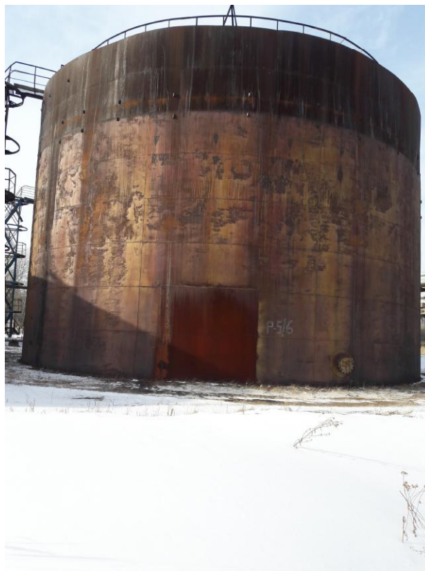
Рисунок 4 - Общий вид резервуара РВС-3000 № 5/6
