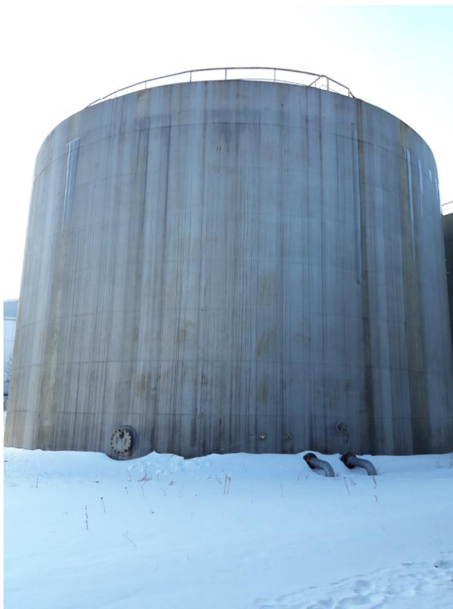
Рисунок 2 - Общий вид резервуара РВС-3000 № 5/4
