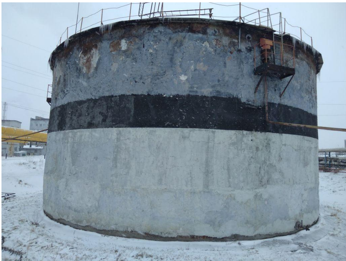
Рисунок 1 - Общий вид резервуара стального вертикального цилиндрического РВС-2000
