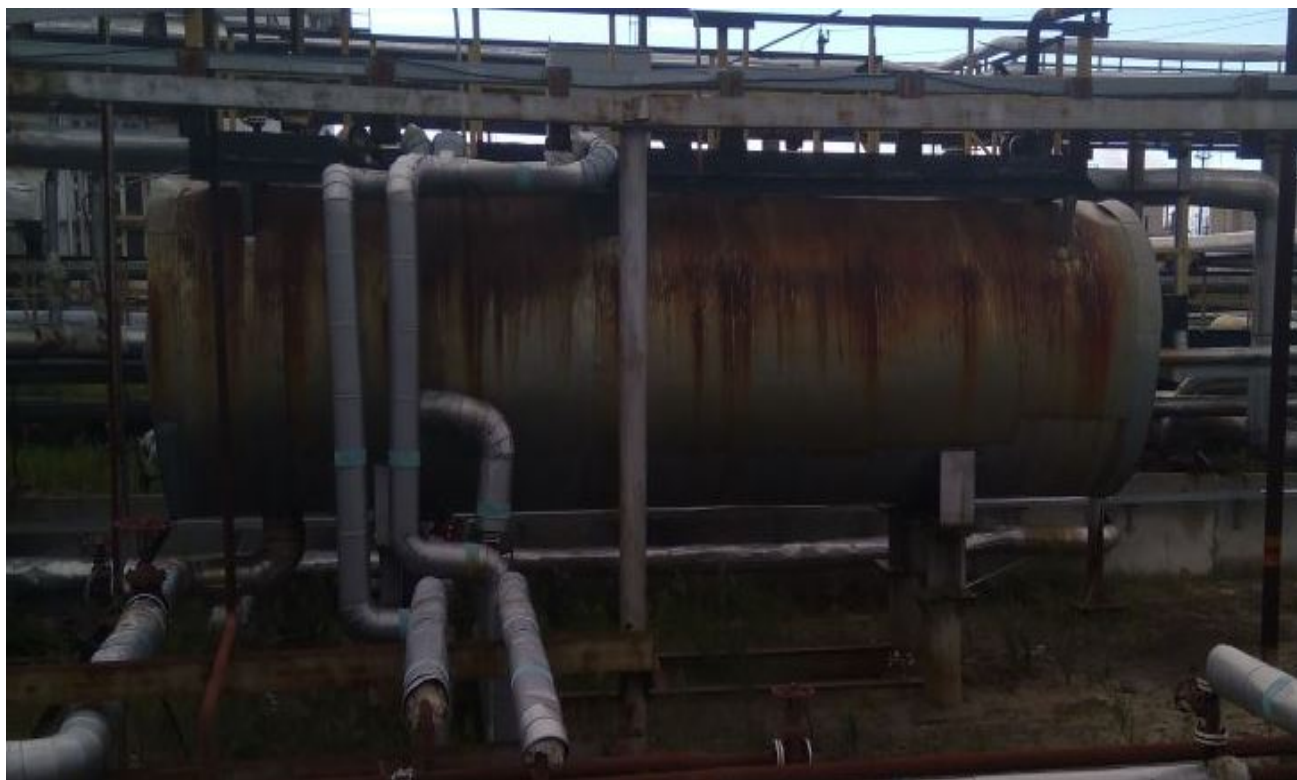
Рисунок 1 - Общий вид резервуара стального горизонтального цилиндрического РГС-25
