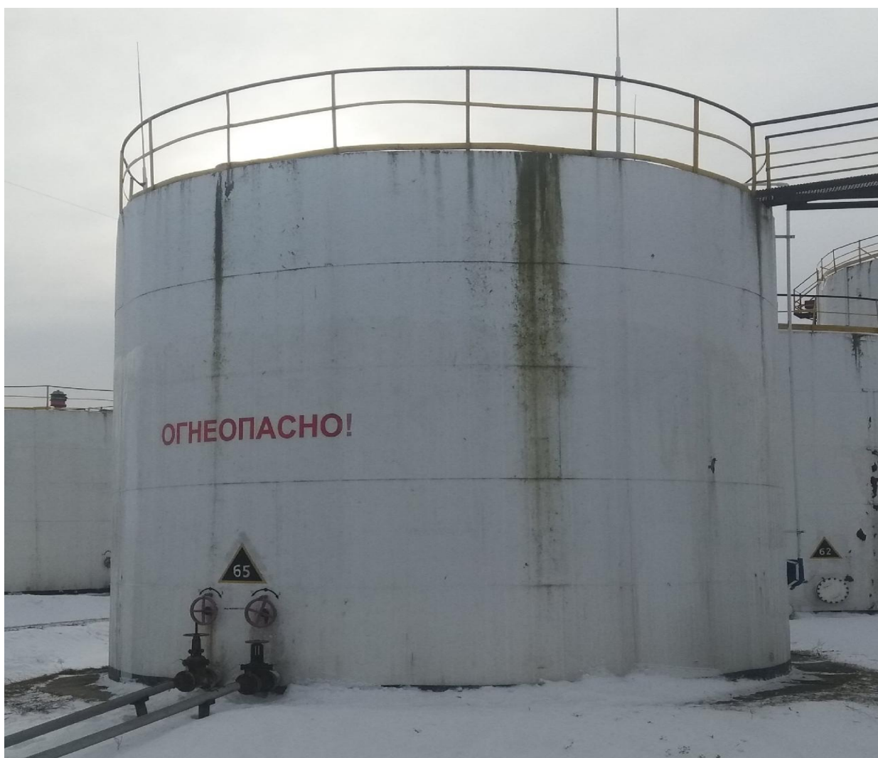
Рисунок 2 – Общий вид резервуара стального вертикального цилиндрического РВС-400
