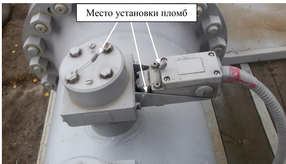
Рисунок 2 – Детектор прохождения шарового поршня. Схема пломбировки от несанкционированного доступа, обозначение места нанесения знака поверки
