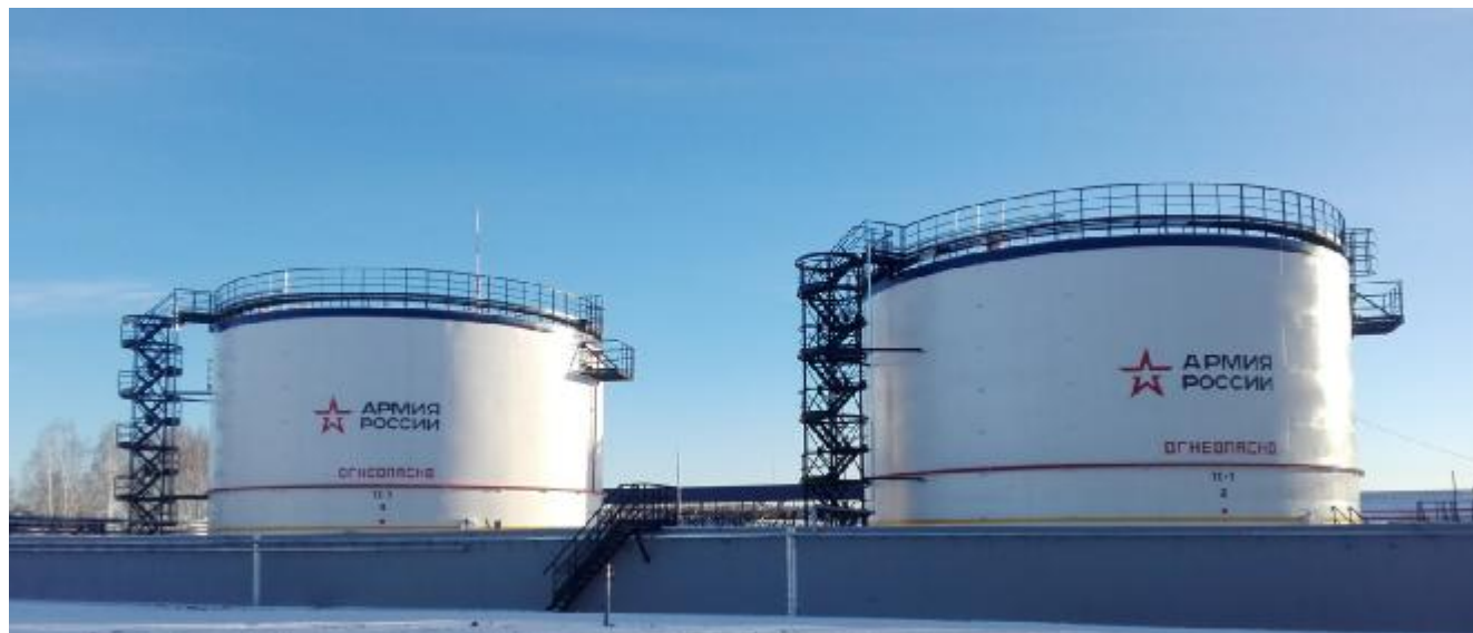
Рисунок 1 – Общий вид резервуаров РВС-3000
