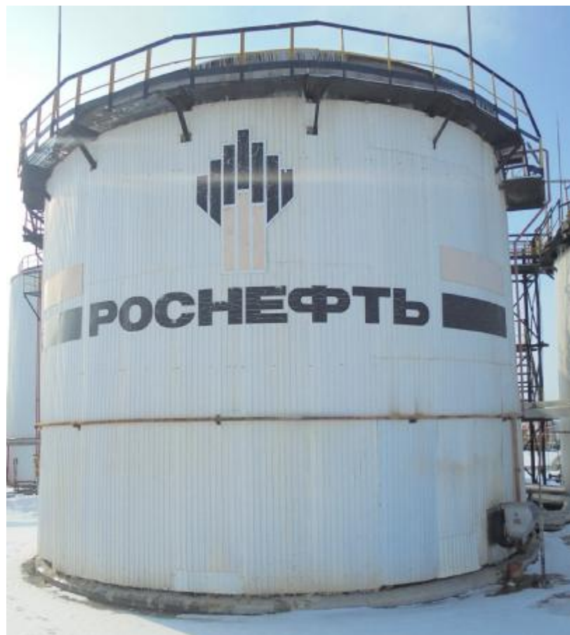
Рисунок 2 – Общий вид резервуара стального вертикального цилиндрического РВС-700
