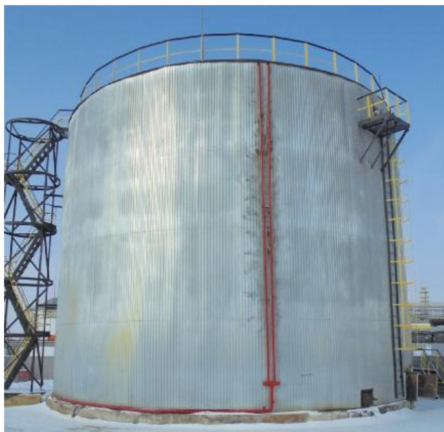
Рисунок 3 – Общий вид резервуара стального вертикального цилиндрического РВС-2000
