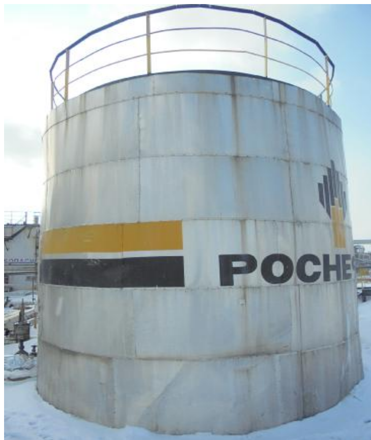
Рисунок 1 – Общий вид резервуара стального вертикального цилиндрического РВС-200
