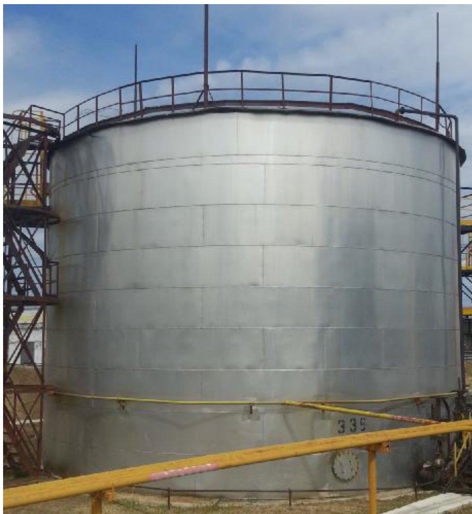
Рисунок 6 - Общий вид резервуара стального вертикального цилиндрического РВС-1000
