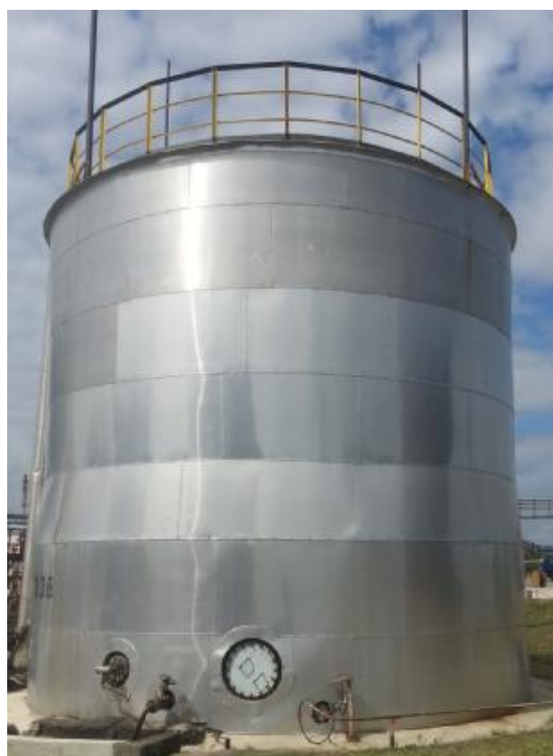
Рисунок 3 - Общий вид резервуара стального вертикального цилиндрического РВС-300
