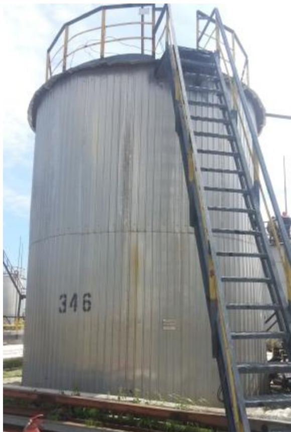
Рисунок 1 - Общий вид резервуара стального вертикального цилиндрического РВС-100
