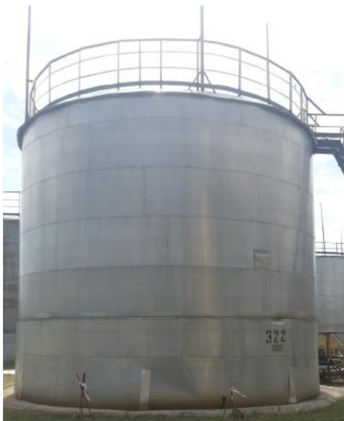
Рисунок 4 - Общий вид резервуара стального вертикального цилиндрического РВС-400
