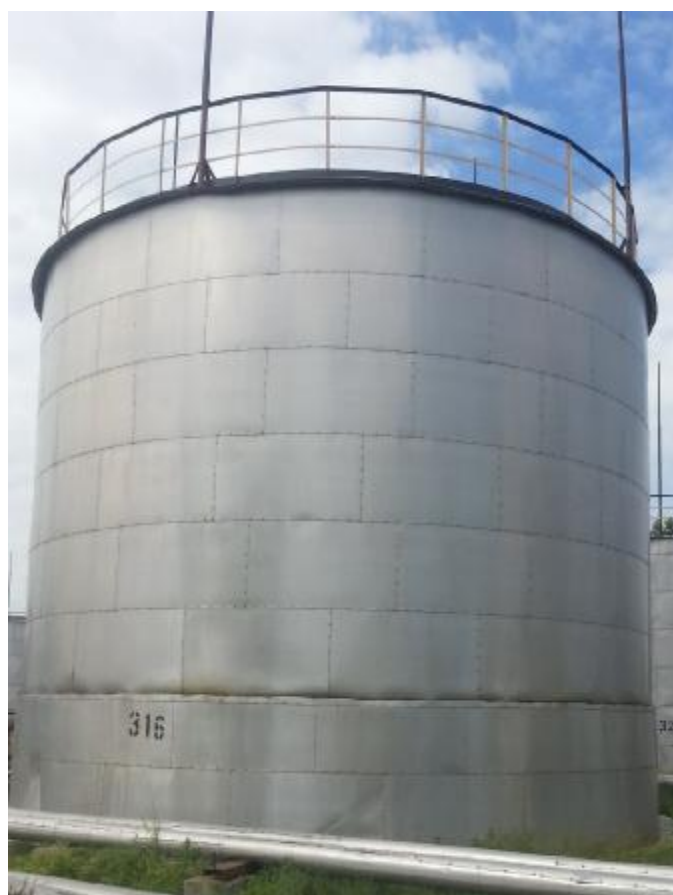
Рисунок 5 - Общий вид резервуара стального вертикального цилиндрического РВС-700
