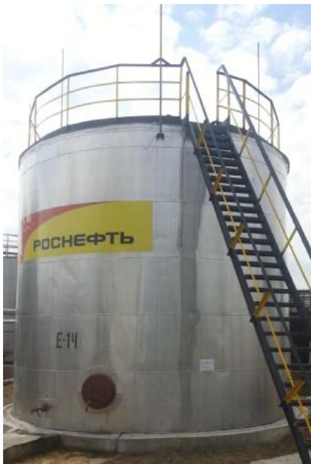
Рисунок 2 - Общий вид резервуара стального вертикального цилиндрического РВС-200
