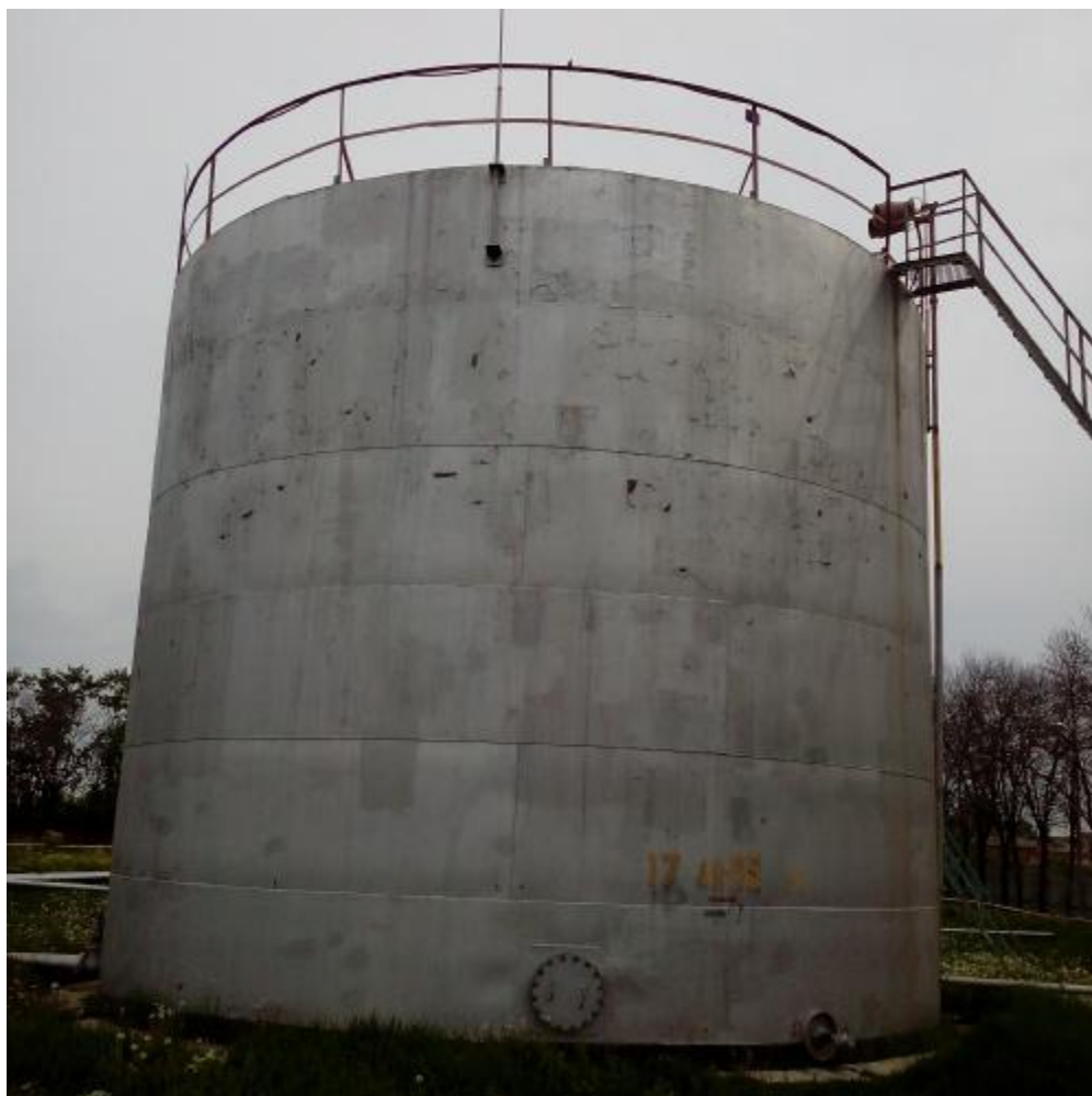
Рисунок 1 - Общий вид резервуара стального вертикального цилиндрического РВС-700
