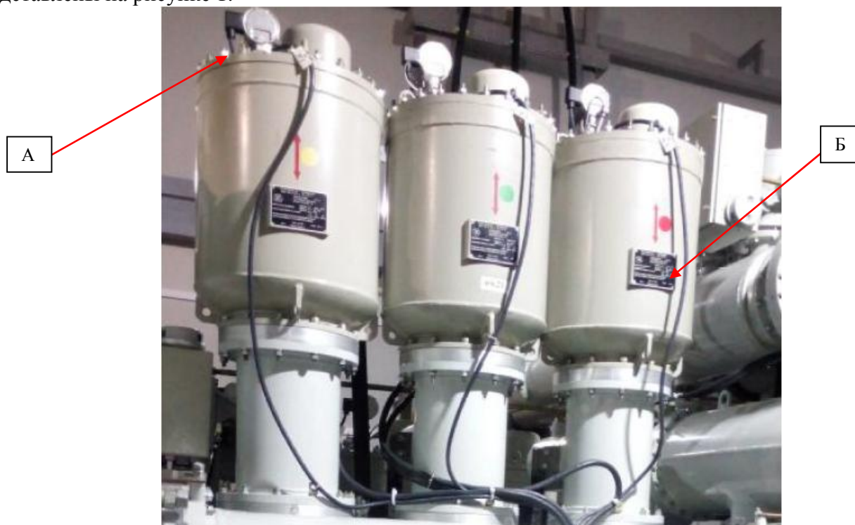
Рисунок 1 – Общий вид средства измерений и обозначение места пломбировки от несанкционированного доступа (А) и места нанесения знака поверки (Б)
