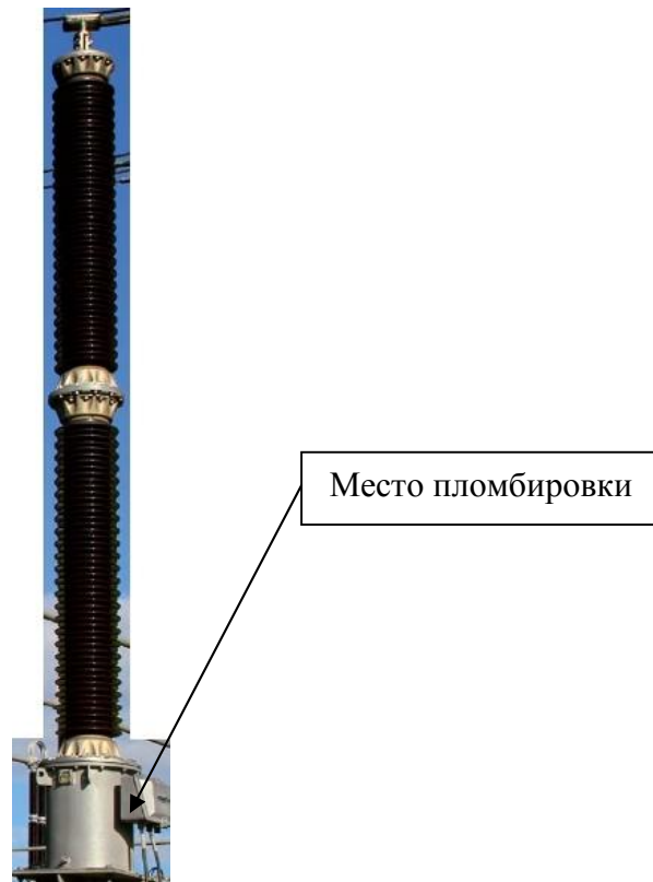
Рисунок 1 – Общий вид средства измерений и схема пломбировки от несанкционированного доступа
