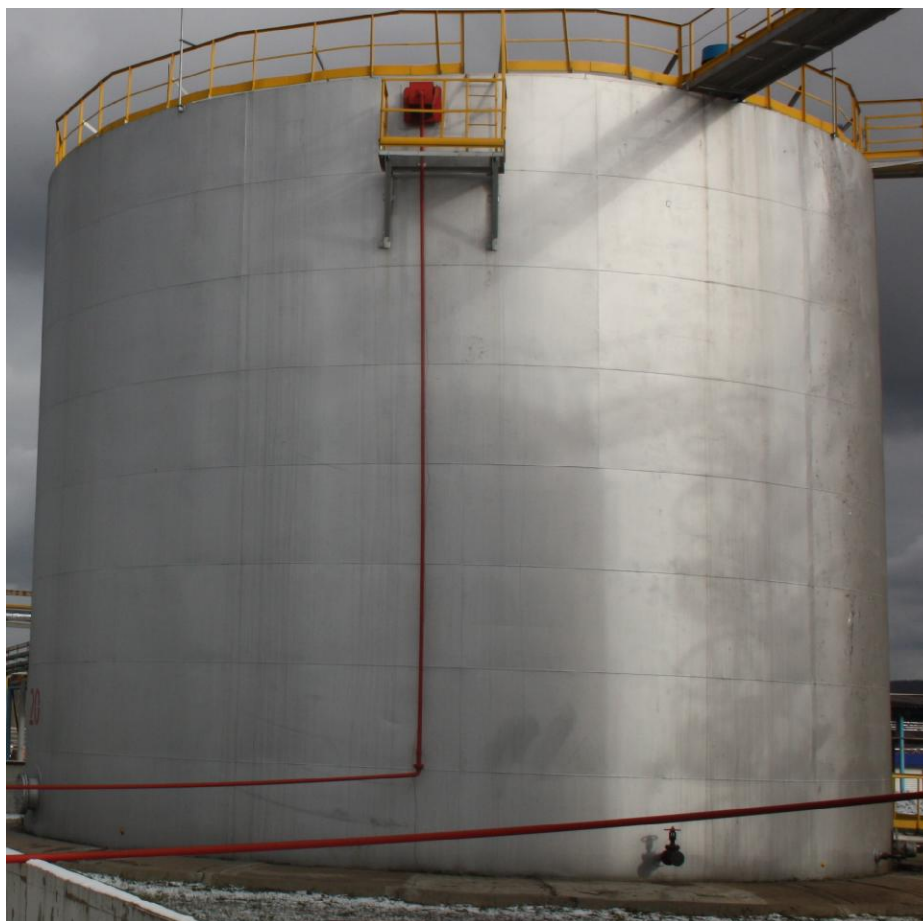
Рисунок 3 - Общий вид резервуара стального вертикального цилиндрического PVC-2000
