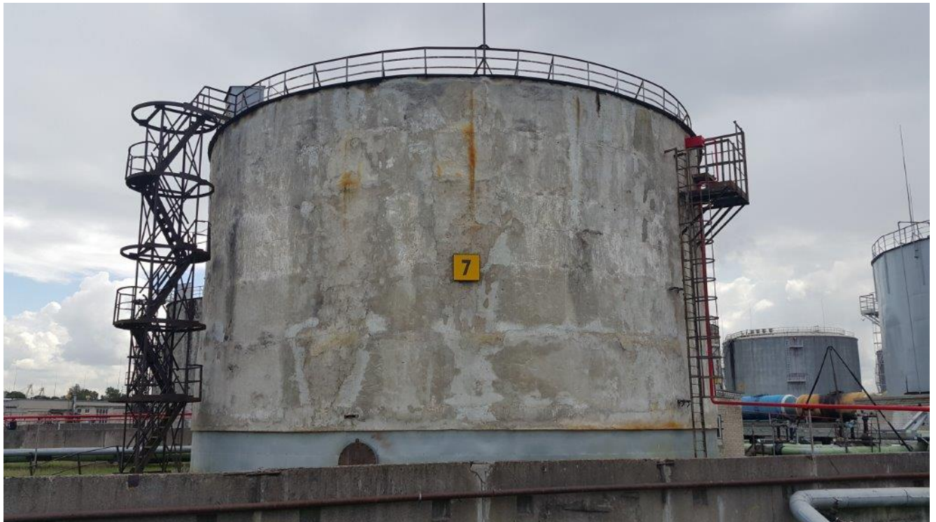
Рисунок 1 - Общий вид резервуара РВСт-3000
