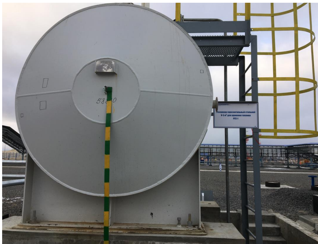
Рисунок 1 - Общий вид резервуара стального горизонтального цилиндрического РГС-5 зав. № 58860
