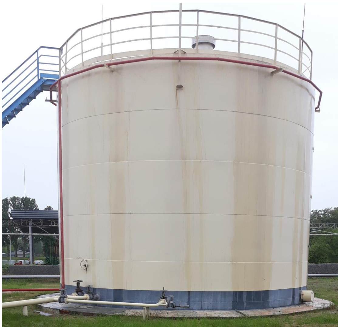
Рисунок 1 - Резервуар стальной вертикальный цилиндрический с понтоном РВСП-400
