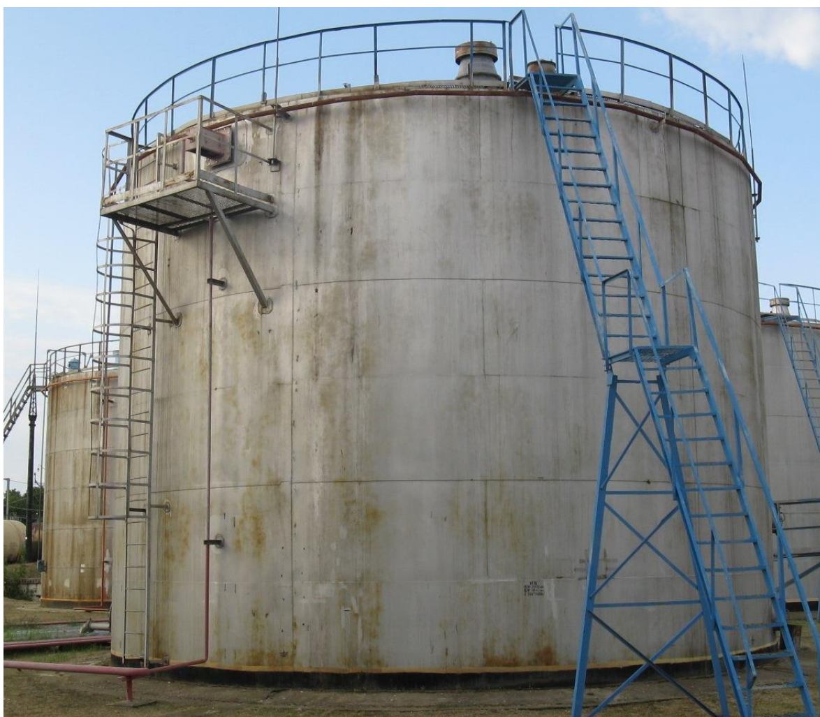
Рисунок 1 - Резервуар стальной вертикальный цилиндрический с понтоном РВСП-1000
