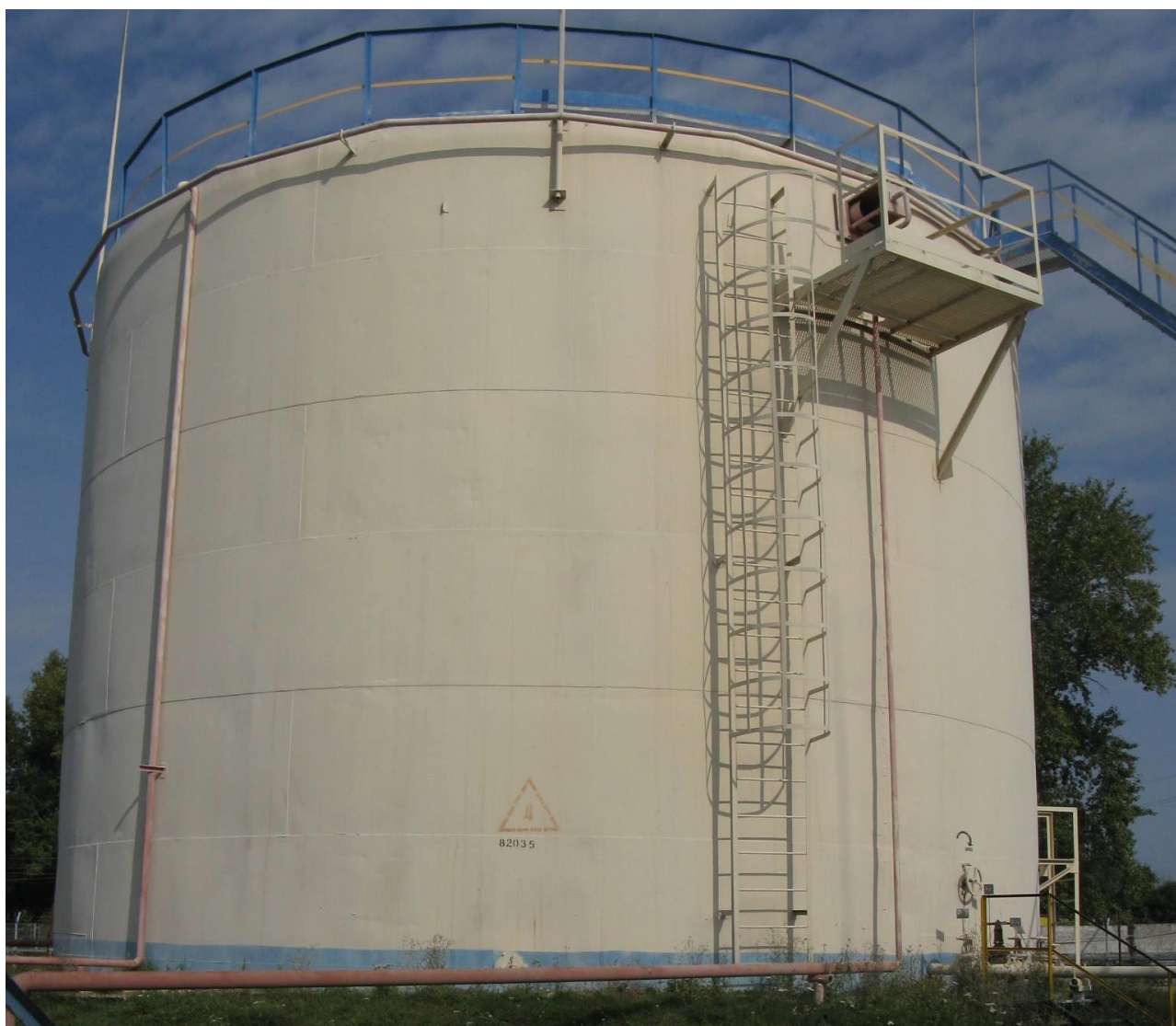
Рисунок 1 - Резервуар стальной вертикальный цилиндрический с понтоном РВСП-1000
