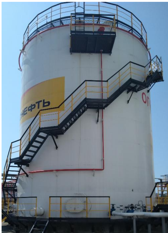
Рисунок 1 - Общий вид резервуара стального вертикального цилиндрического РВС-1000
