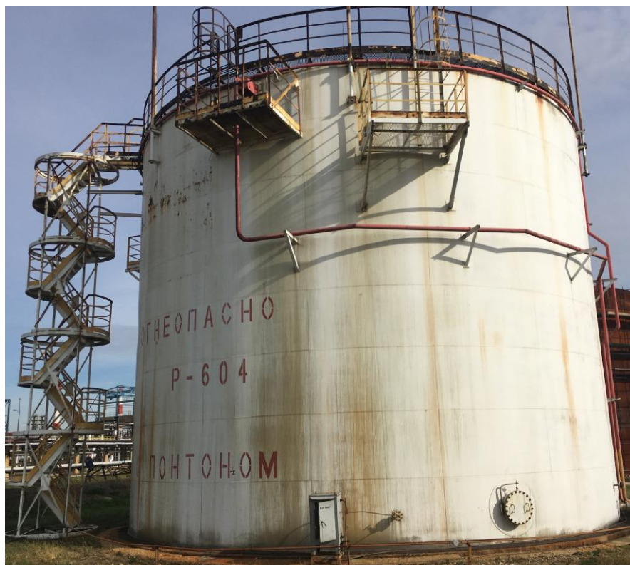
Рисунок 6 - Общий вид резервуара стального вертикального цилиндрического РВС-2000, РВСП-2000
