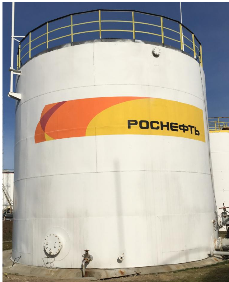
Рисунок 3 - Общий вид резервуара стального вертикального цилиндрического РВС-400
