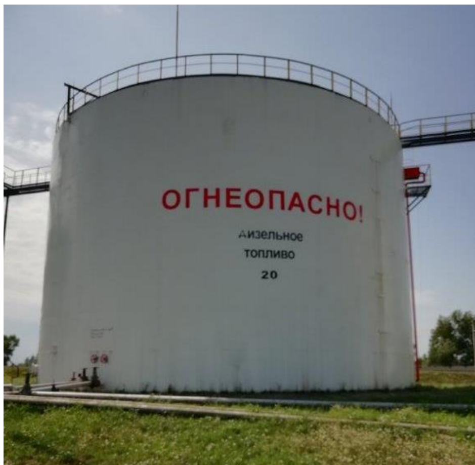
Рисунок 1 - Общий вид резервуара стального вертикального цилиндрического РВС-3000
