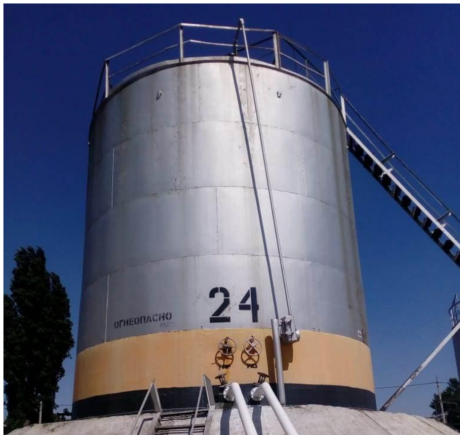
Рисунок 1 - Общий вид резервуара стального вертикального цилиндрического РВС-200
