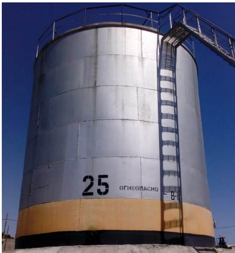
Рисунок 2 - Общий вид резервуара стального вертикального цилиндрического РВС-400
