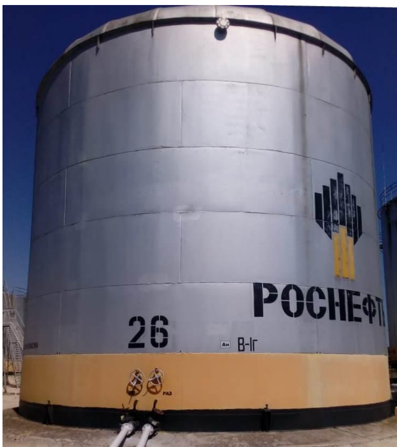
Рисунок 3 - Общий вид резервуара стального вертикального цилиндрического РВС-700
