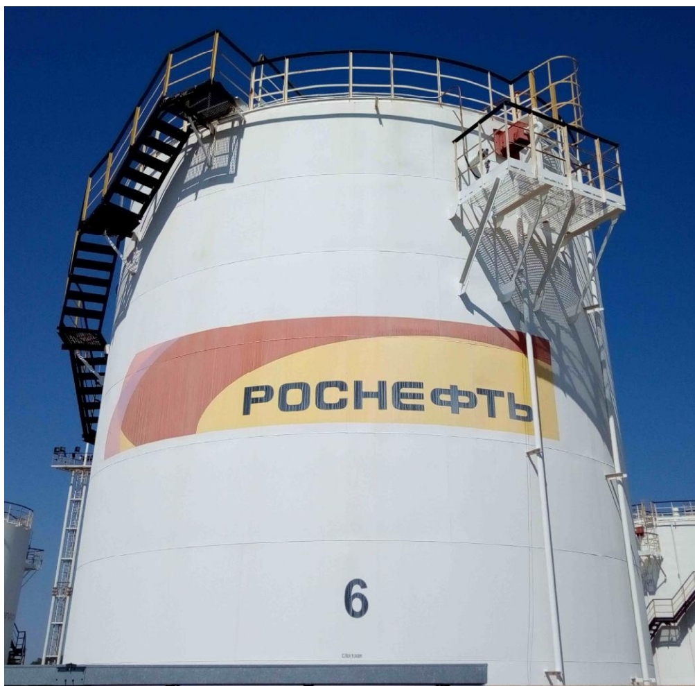
Рисунок 1 - Общий вид резервуара стального вертикального цилиндрического РВС-1000
