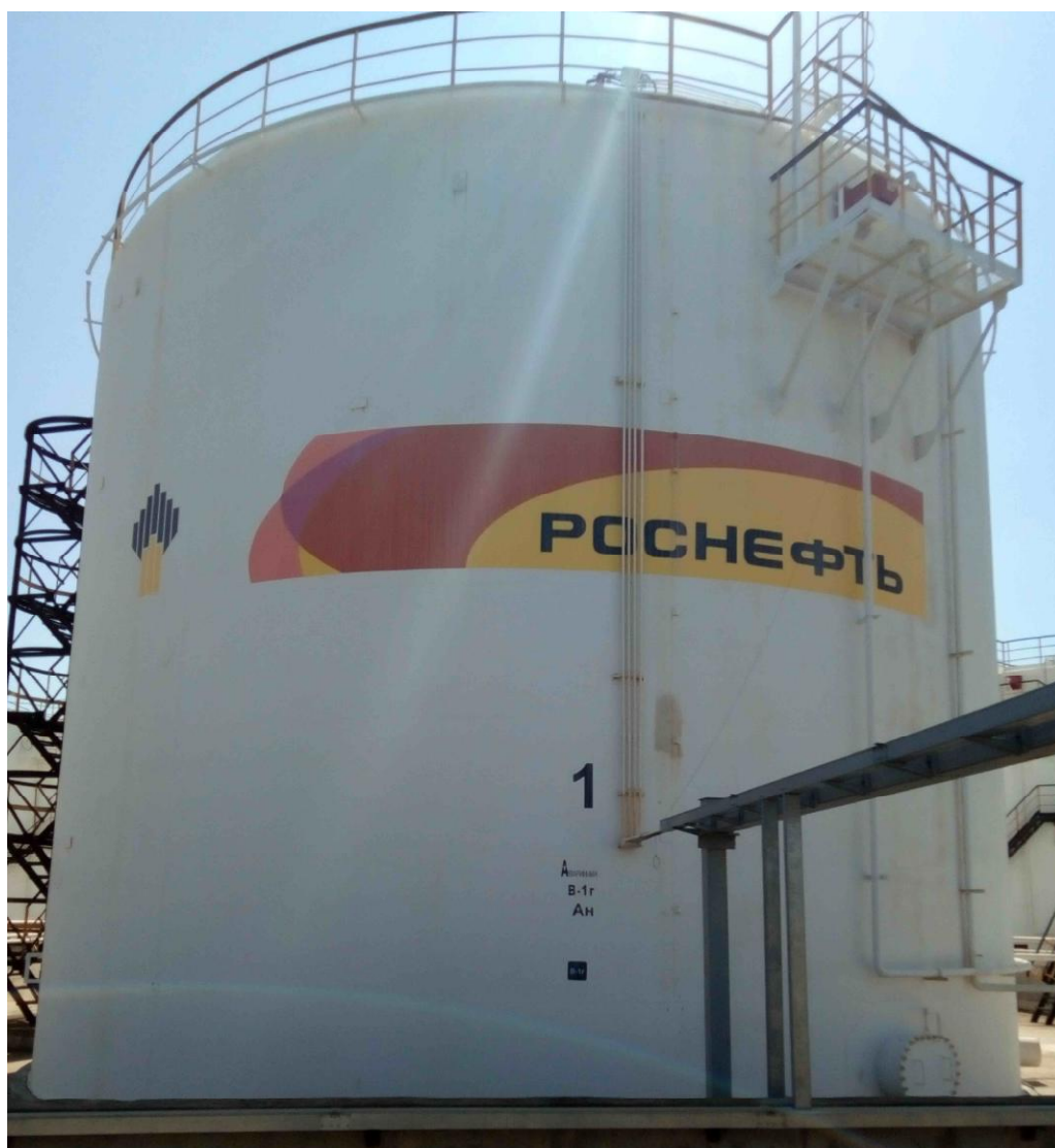
Рисунок 2 - Общий вид резервуара стального вертикального цилиндрического РВС-2000
