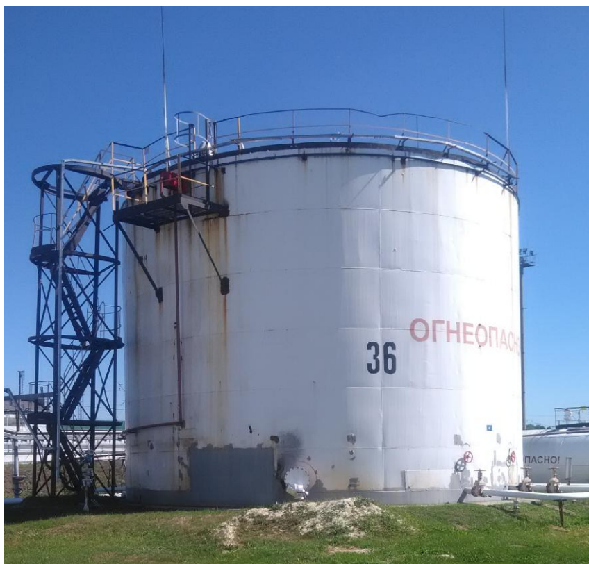
Рисунок 1 - Общий вид резервуара РВС-1000
