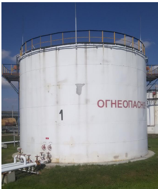
Рисунок 1 - Общий вид резервуара
