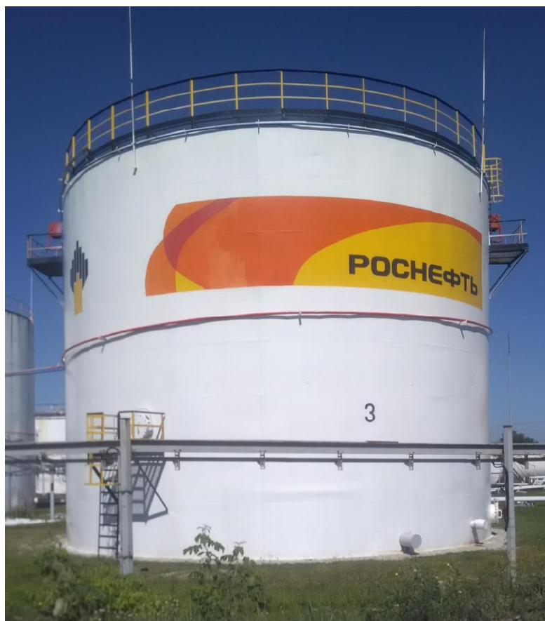
Рисунок 4 - Общий вид резервуара РВСП-2000 № 3
