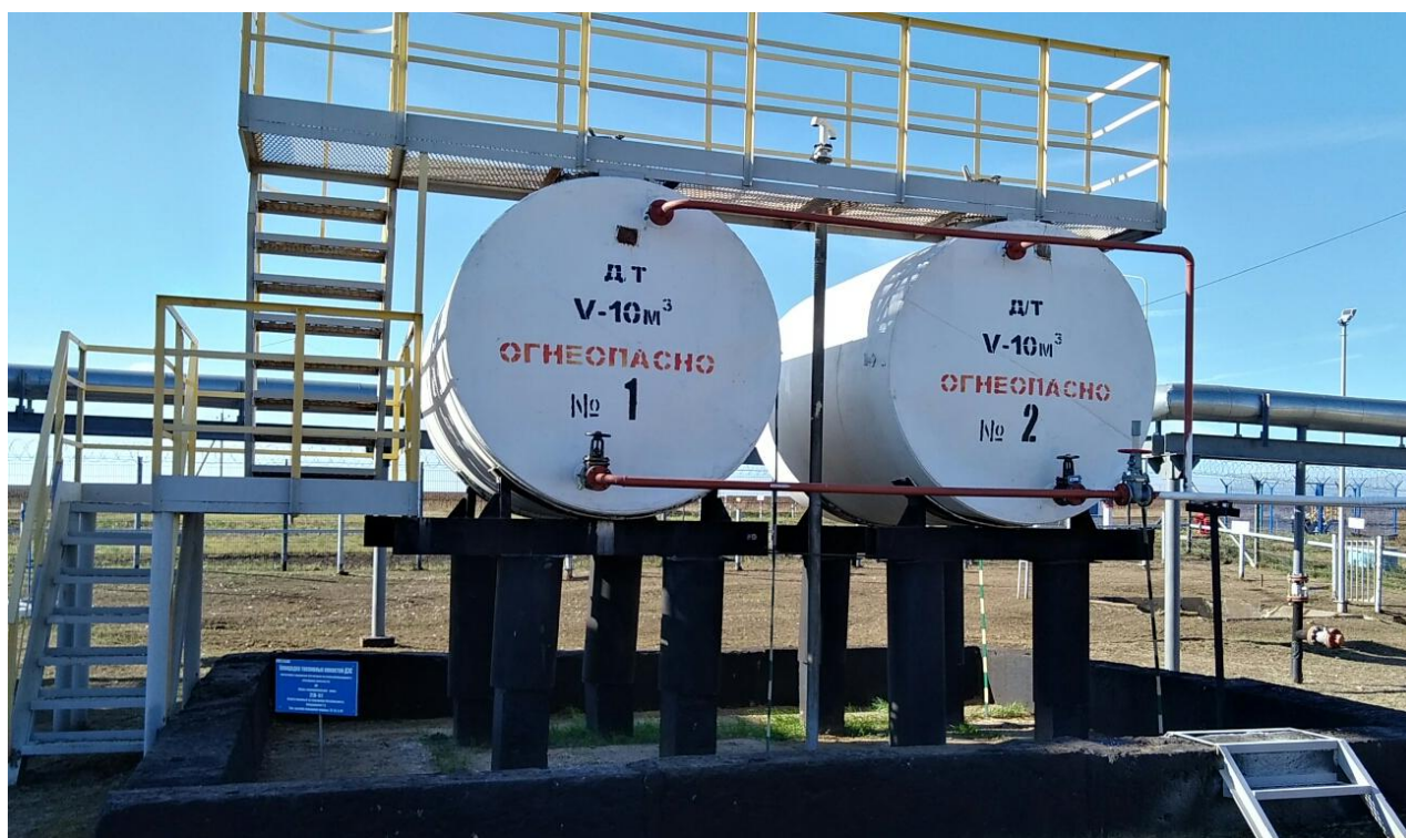
Рисунок 2 - Общий вид резервуара РГС-10 № 1, 2 (ЛПДС «Андеяновская»)
